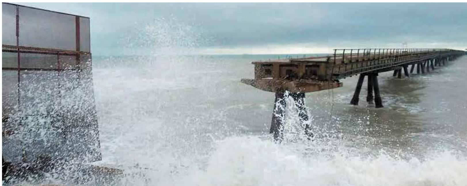
Estado del Pantalán tras el derrumbe de uno de los vanos a causa de un fuerte temporal. / APV
