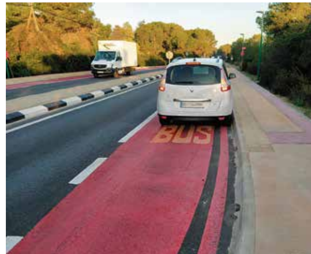
La estrecha parada del bus en la CV-500. / EPDA
