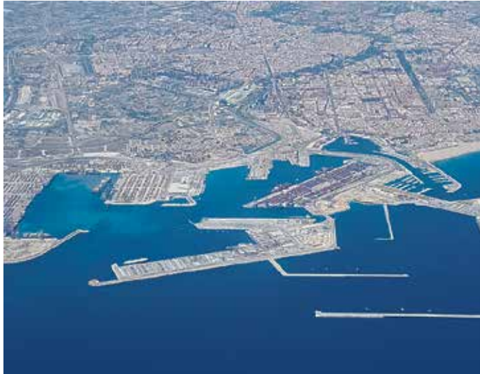
Vista aérea del Puerto de València. / EPDA
