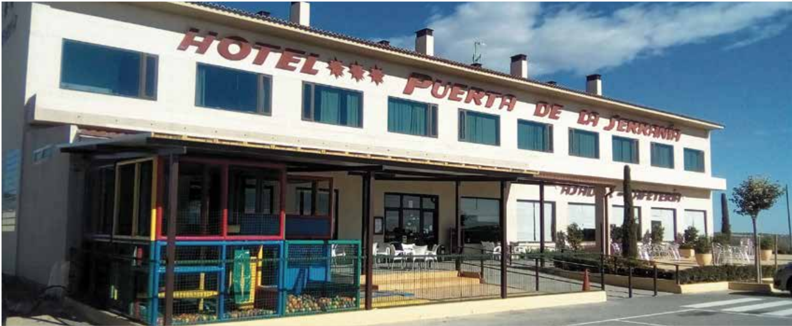
Panorámica del Hotel Puerta de La Serranía de Lliria, cuyas instalaciones se han ofrecido al Hospital de Lliria. / EPDA
