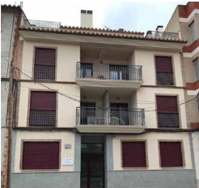
Edificio de viviendas. / EPDA
