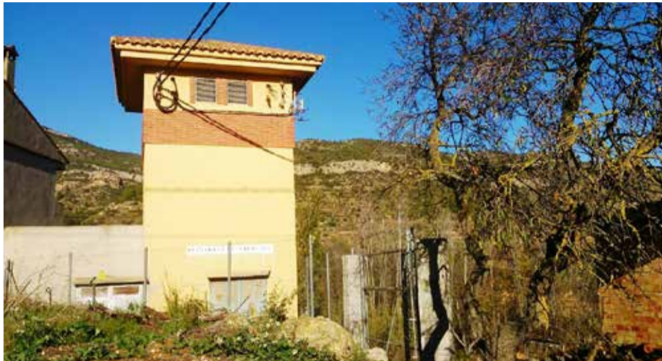
Centro transformador de la cooperativa. / IMAGEN CEDIDA POR LA COOPERATIVA
