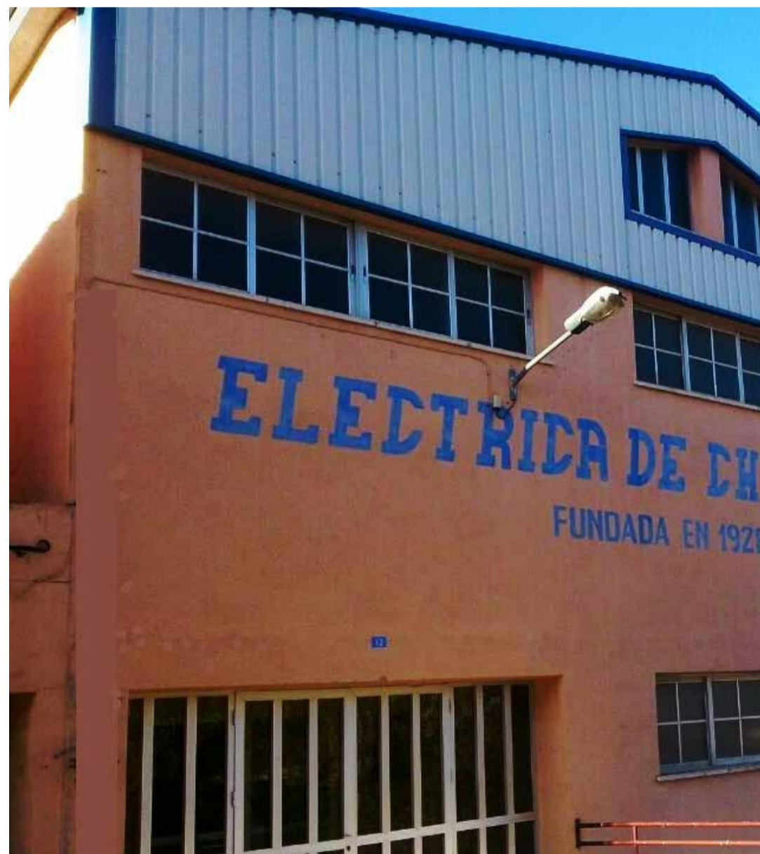
Fachada de la Cooperativa Eléctrica de Chera. / IMAGEN CEDIDA POR LA COOPERATIVA
