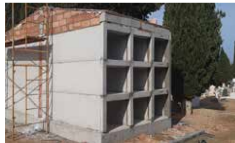
Finalización de la obra. / EPDA
