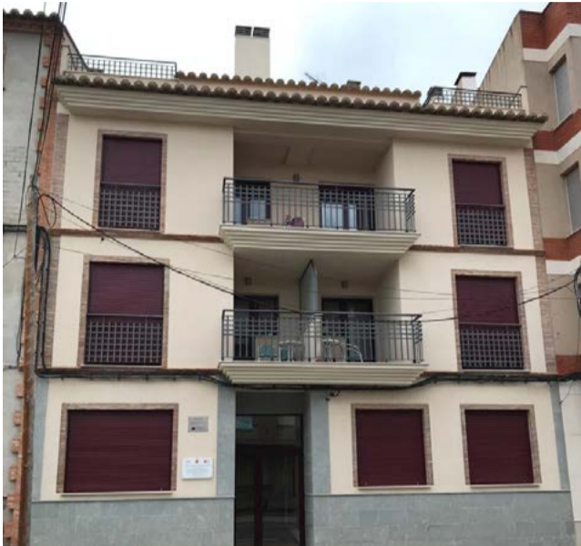
Edificio de viviendas. / EPDA
