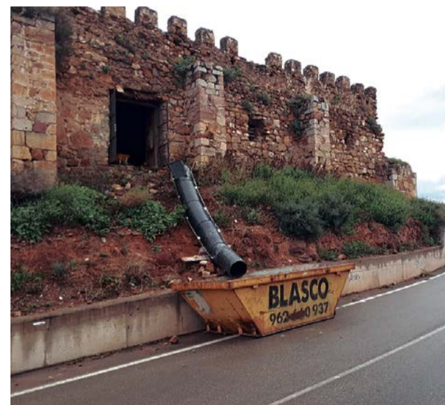
Trabajos en el castillo de Petrés. / EPDA
