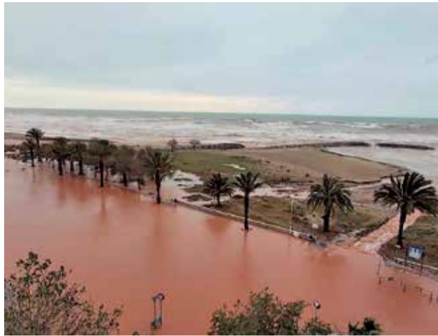
Paseo marítimo de Port de Sagunt inundado. / EPDA
