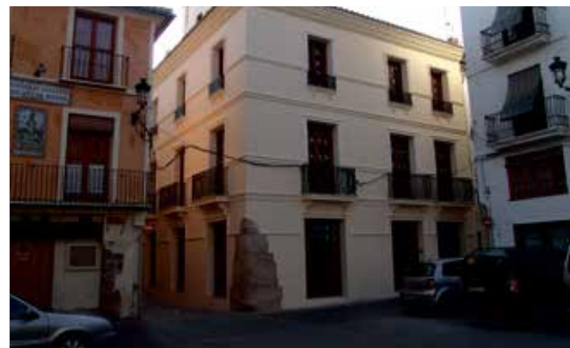
Edificio del CEDES en Segorbe. / EPDA
