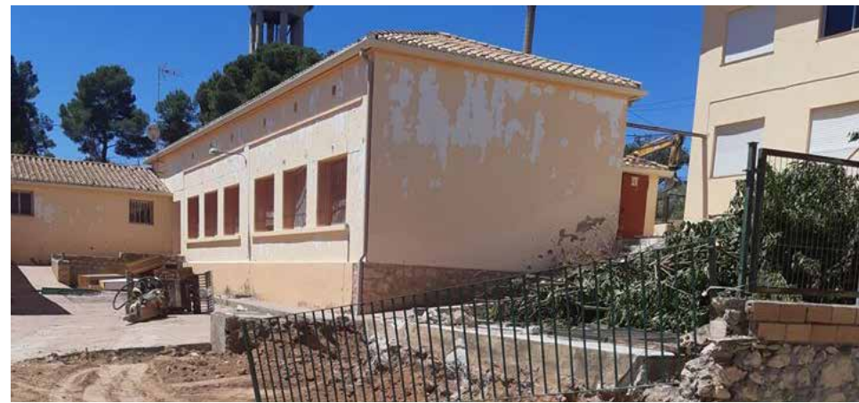
Trabajos de demolición en el viejo colegio. / EPDA
