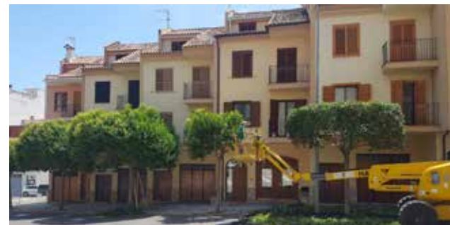
Trabajos en la avda. Sierra Espadán. / EPDA
