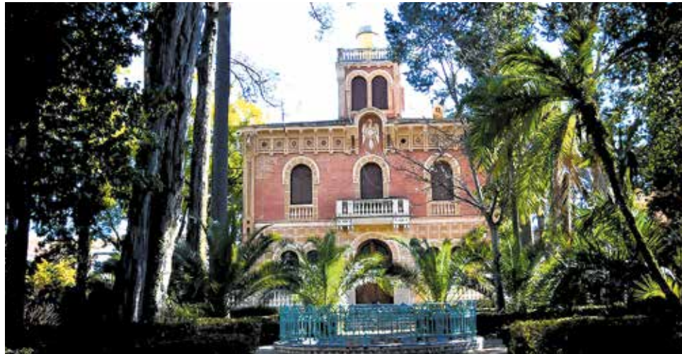
Uno de los edificios más emblemáticos en el casco urbano de Bétera. / EPDA
