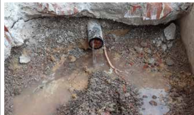
Reparación de la red de agua del municipio. / EPDA
