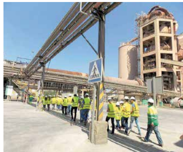
Planta de Lafarge en Sagunt. / EPDA
