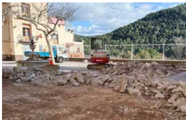
Las obras de la plaza adelantan. / FOTO: M.REQUENI
