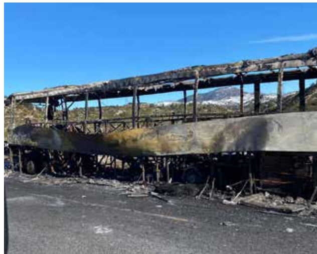
Estado del autobus tras el incendio. / M.MARTÍN
