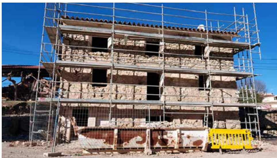
El edificio en obras. / EPDA
