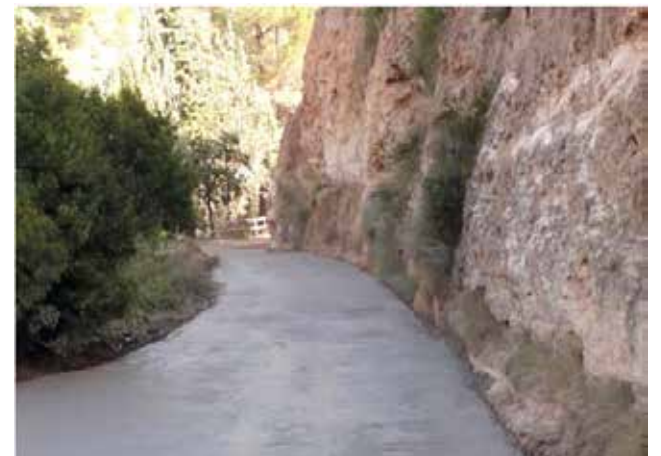
Trabajos finalizados en el camino. / EPDA
