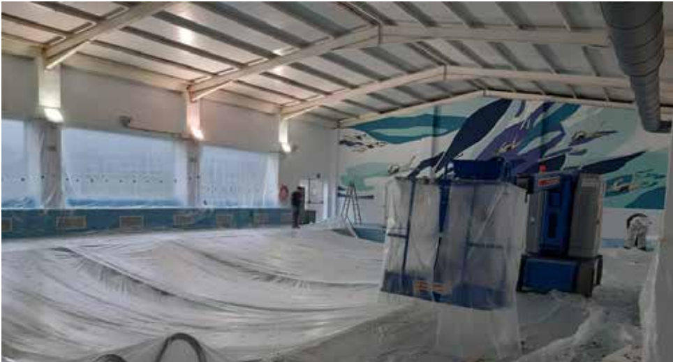
La piscina cubierta en obras / EPDA
