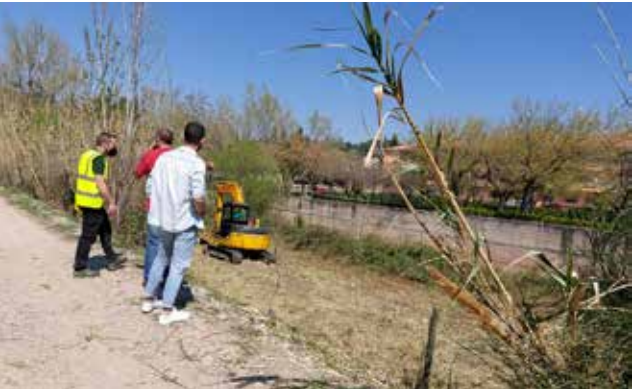
Máquinas trabajando en el cauce/ EPDA
