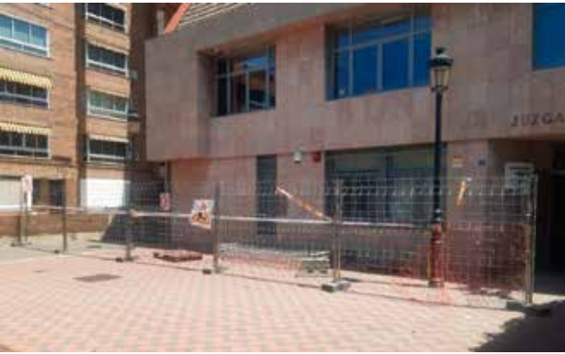
El edificio del juzgado en obras / EPDA
