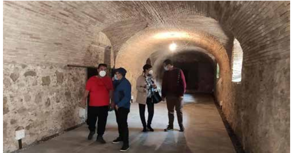
Galería bajo a Glorieta / EPDA
