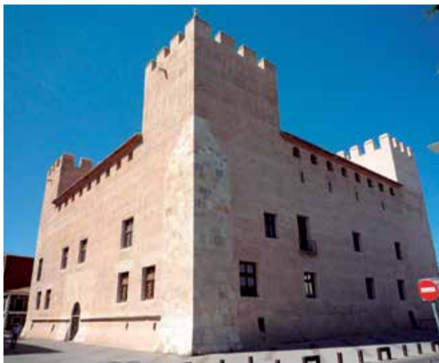
Fachada del Castell d'Alaquàs / EPDA
