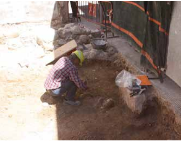
Excavación en el solar. / EPDA
