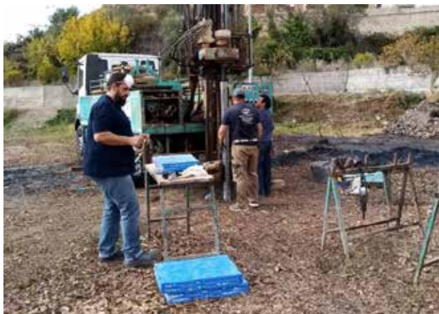
Trabajos previos para el aula de Castellnovo. / EPDA
