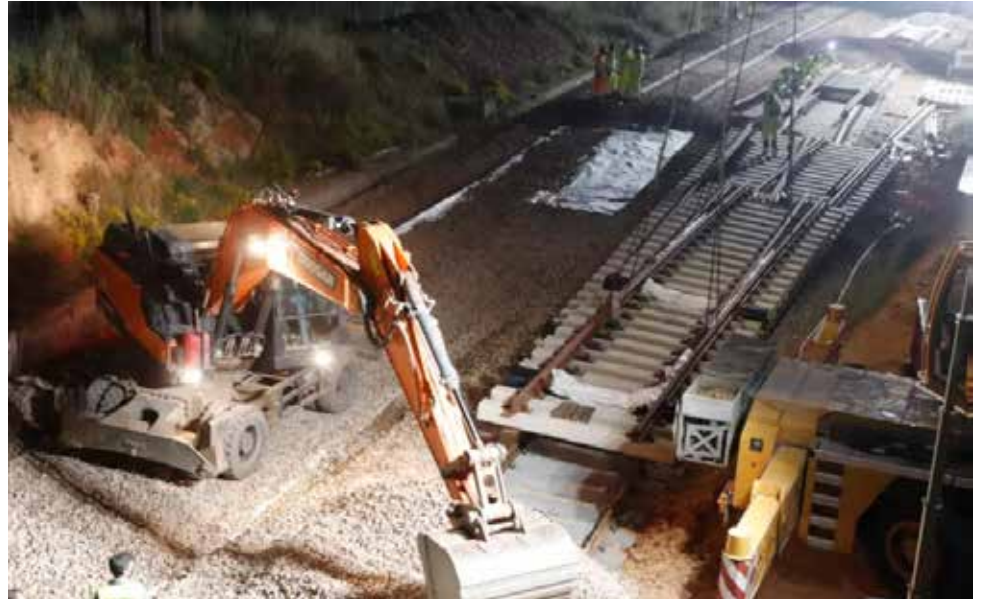
Obras en la estación de Barracas / EPDA
