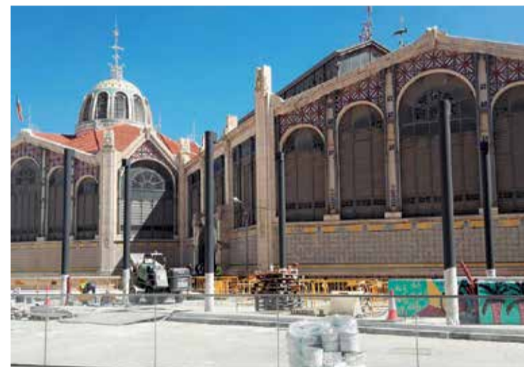
Montaje de las pérgolas. / EPDA
