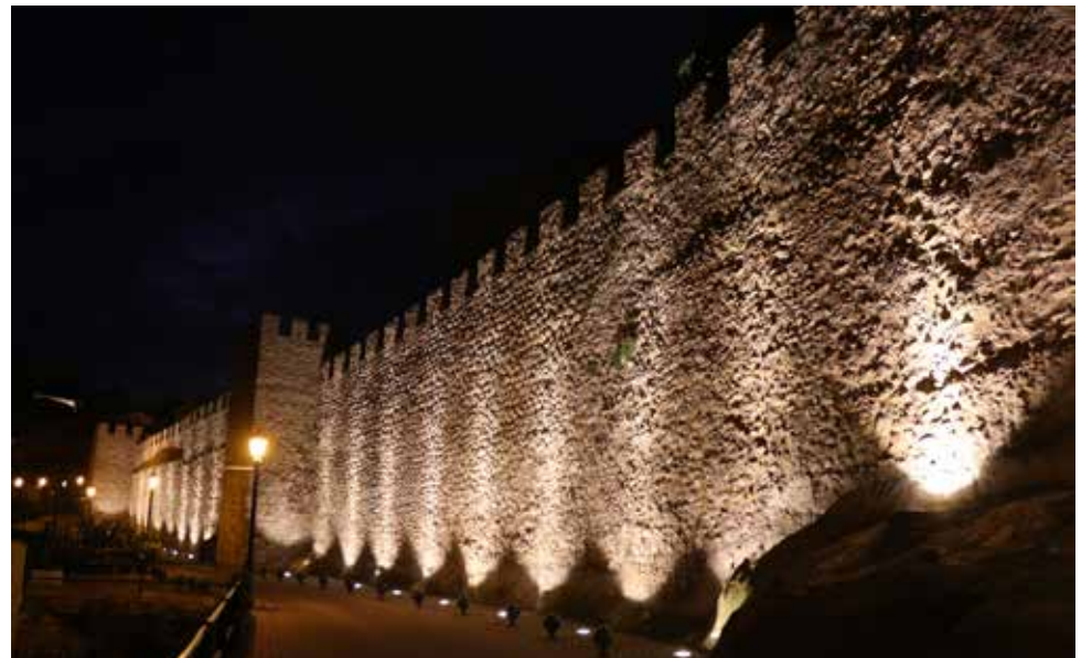
Cortinas de la muralla de la calle Argén con la nueva iluminación / EPDA
