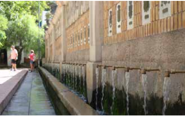
La fuente con los caños ya repuestos. / EPDA
