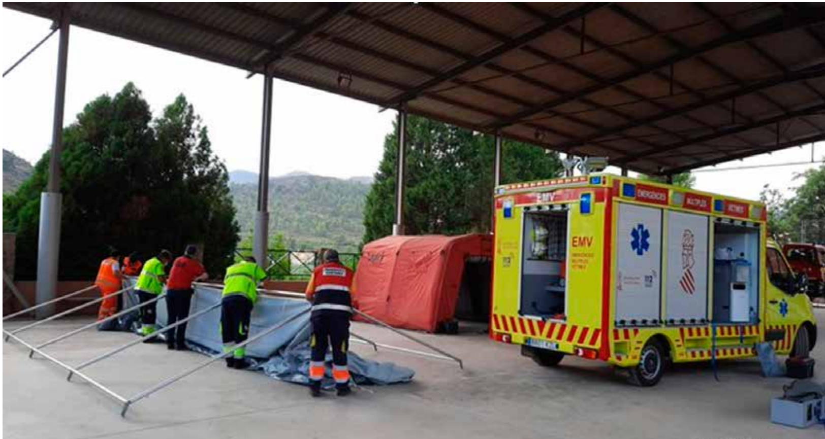
Montaje del hospital de campaña en la Puesto de Mando Avanzado (PMA) de la piscina de Azuébar / EPDA
