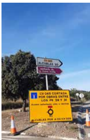
Carretera en obras. / EPDA
