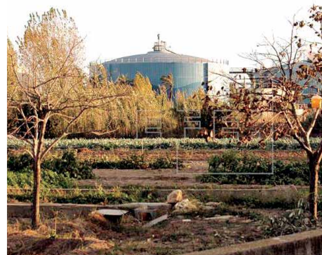
Depuradora de Pinedo. / EPDA
