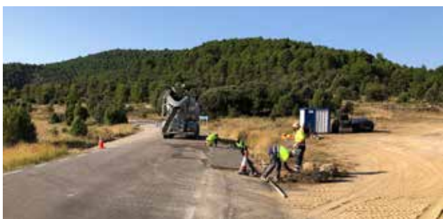
Carretera en obras / FOTO:ARCHIVO
