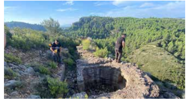
Importantes construcciones de la Línea X,Y,Z / EPDA
