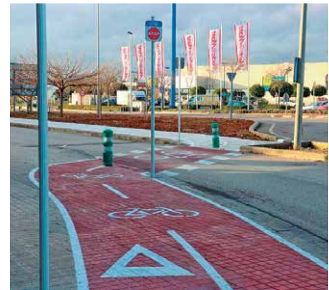
Trabajos en el polígono de Quart. / EPDA
