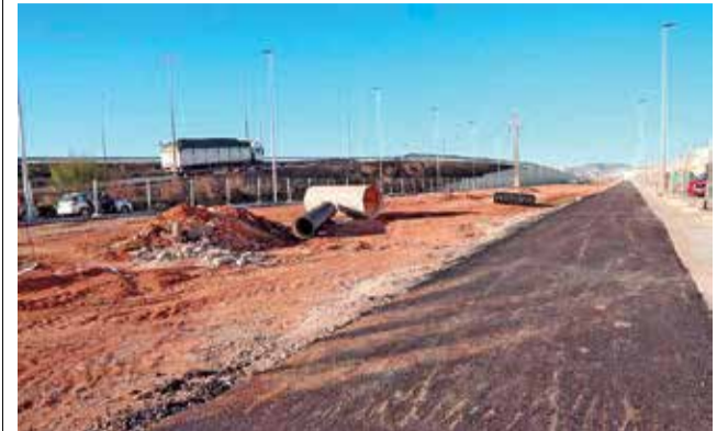
Obres a Alaquàs. / EPDA
