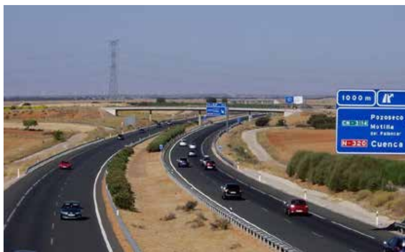
Autovía de la A-3. / EPDA
