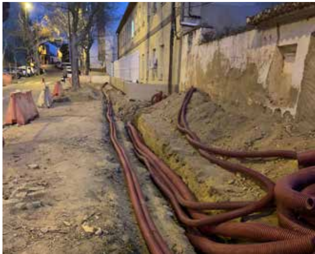
Obras en Buñol. / EPDA
