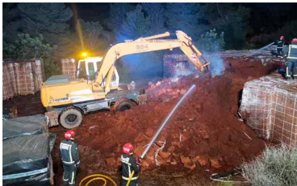
Los bomberos trabajando en la extinción. / EPDA
