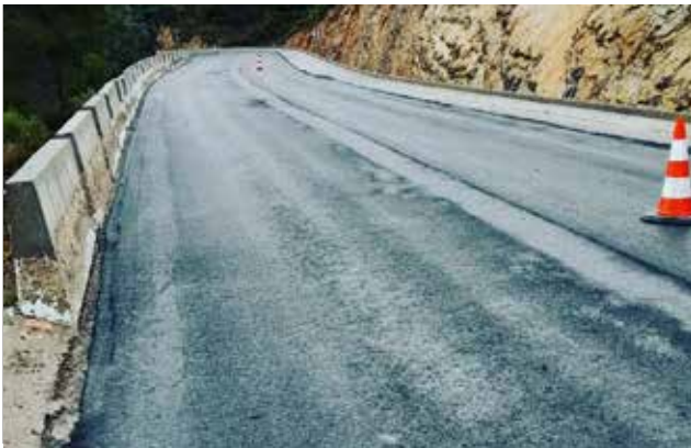
Poco antes de la finalización de las obras. / EPDA
