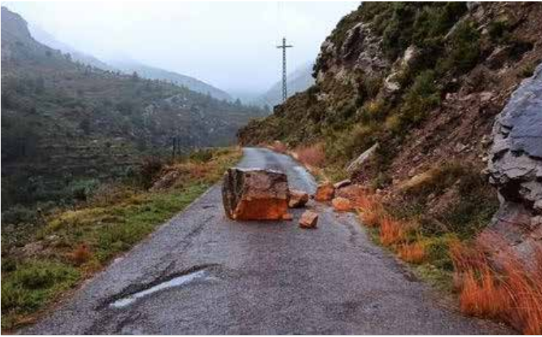
Desprendimiento entre Bejís y Arteas. / EPDA
