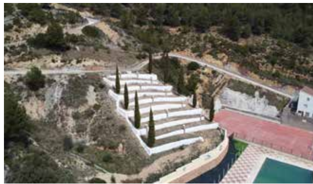
Vista área tras los trabajos. / EPDA
