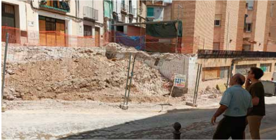
La alcaldesa con Pepe Muñoz en las obras. / EPDA
