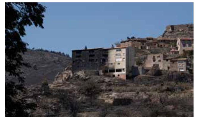
Edificio afectado por las llamas en Bejís./ EPDA
