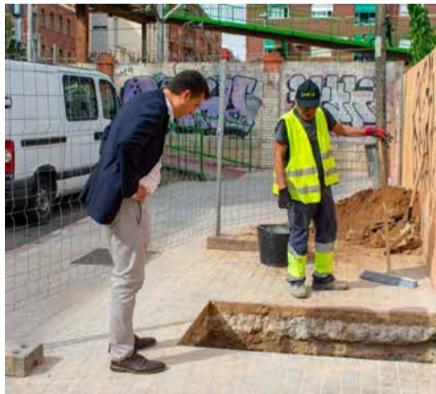
Visita a las obras de l'Alqueria del Pi. / EPDA
