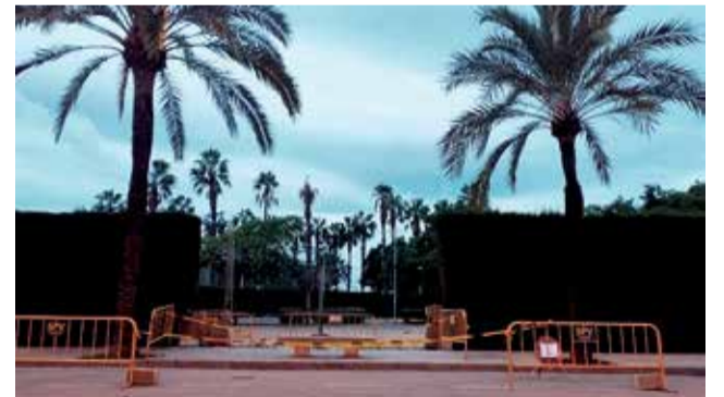
Obres a la zona del poliesportiu. / EPDA
