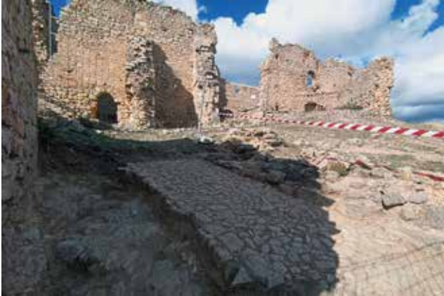
Obras actuales en el castillo de El Toro. / EPDA
