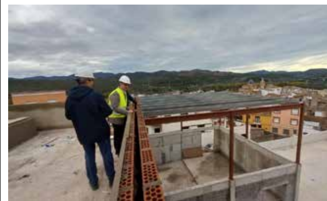
Visita a las obras del IES de Soneja. / EPDA
