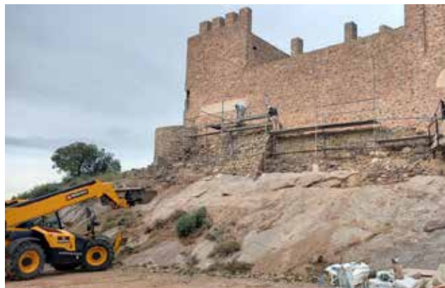
Mejoras en la fachada sur. / EPDA
