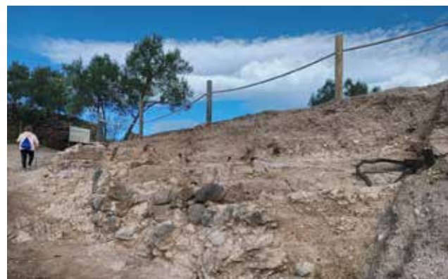
Consolidación del muro exterior. / EPDA
