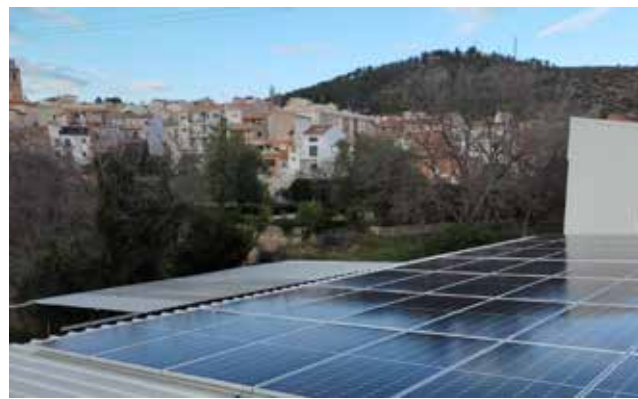
Instalación de placas en Viver. / EPDA
