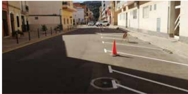
Trabajos de pintura vial. / EPDA
