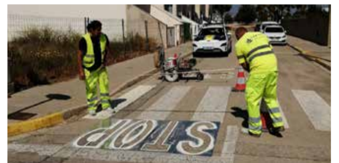
Operarios realizan trabajos de pintura. / EPDA
