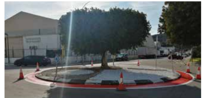
Trabajos de pintura vial. / EPDA
