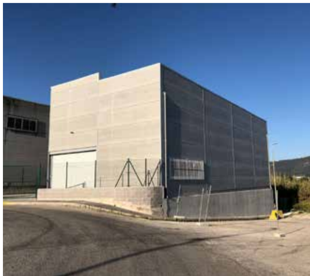
Nou magatzem municipal al polígon industrial. / EPDA
