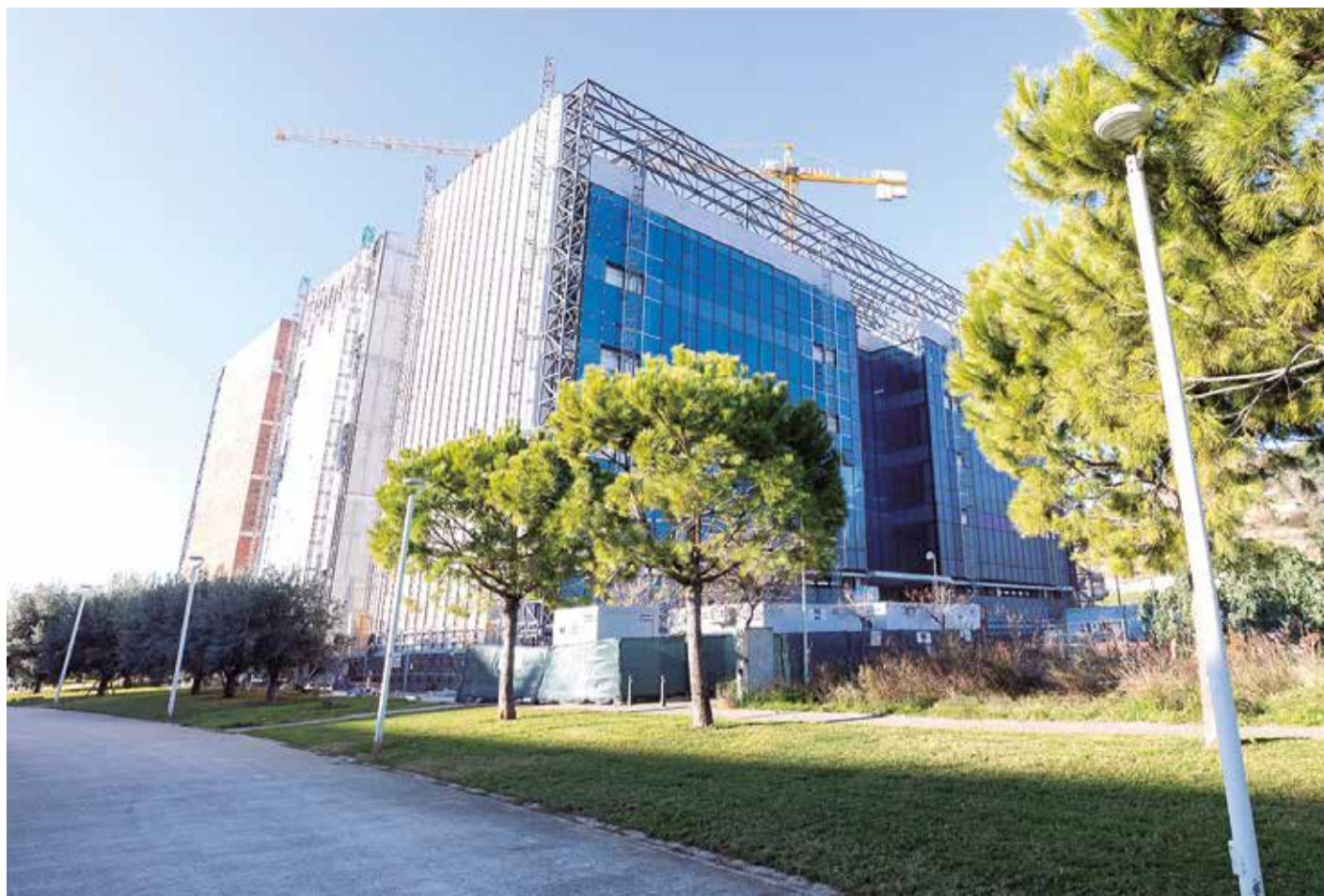
Obras del nuevo Palacio de Justicia de Gandia. / ÀLEX OLTRA
