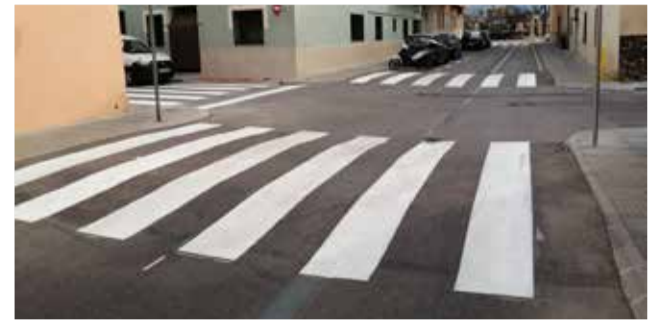
Trabajos de pintura vial. / EPDA
