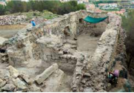
Trabajos sobre la iglesia. / EPDA
