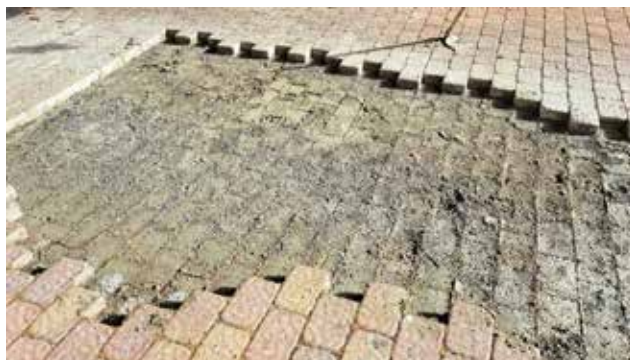
Corrigiendo el hundimiento. / EPDA
