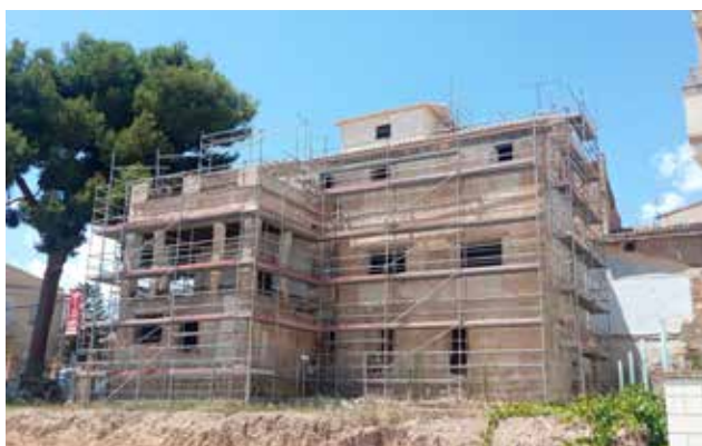
Los andamios cubren una de las fachadas. / EPDA
