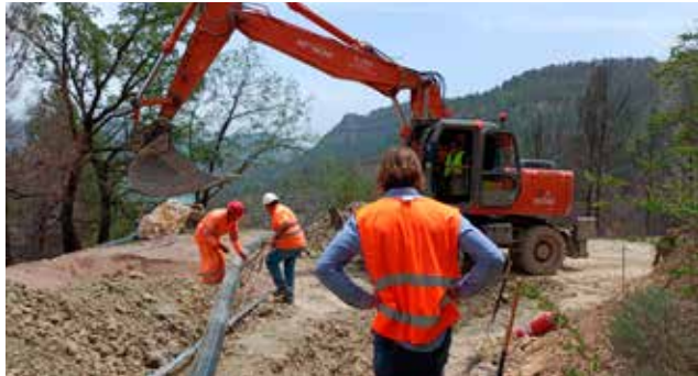
Trabajos de reposición de la tubería. / EPDA
