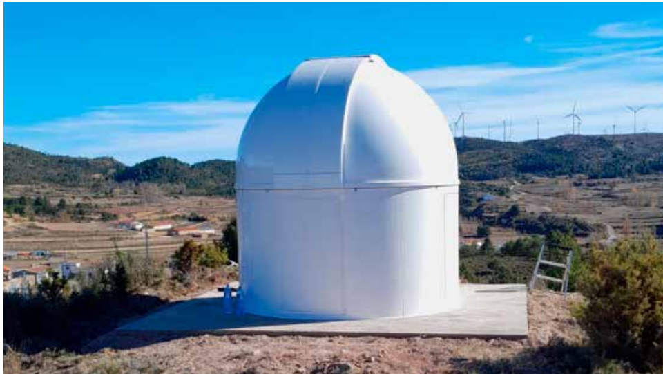
El observatorio con las obras terminadas./ EPDA
