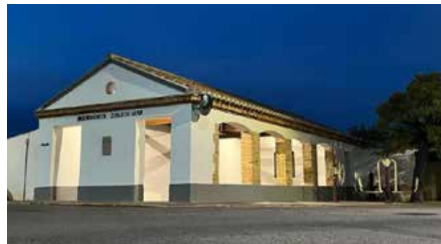
Finalizadas las obras en el lavadero. / EPDA
