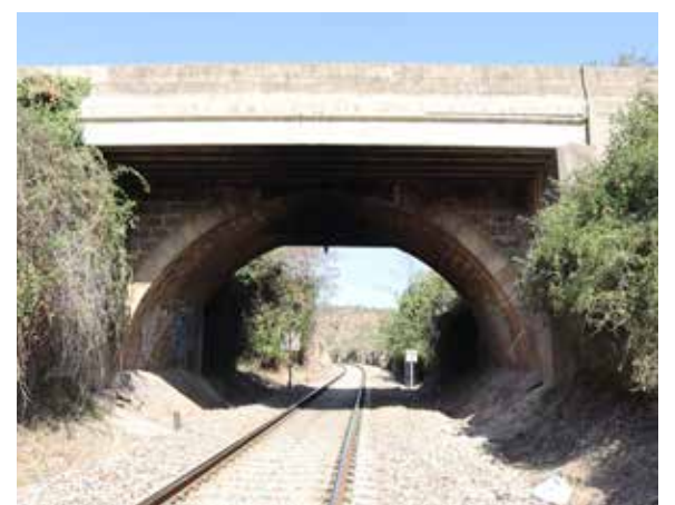
Segorbe km 235+120 Paso carretera N-234./ EPDA
