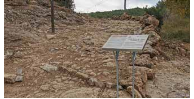
Restauración y señalización del camino. / EPDA
