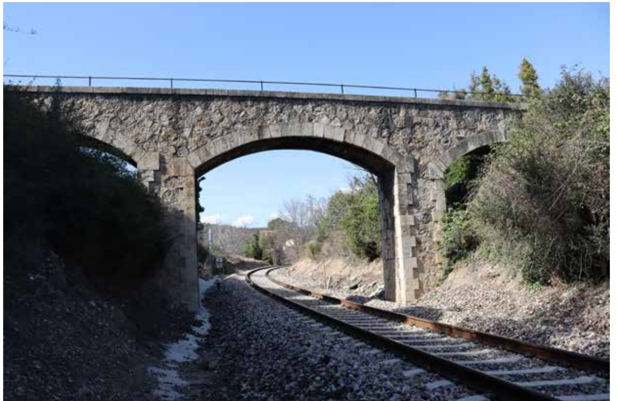
Segorbe km 235+820 Paso superior acueducto (partida El Chopo)./ EPDA
