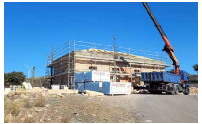
Las obras en marcha. / EPDA
