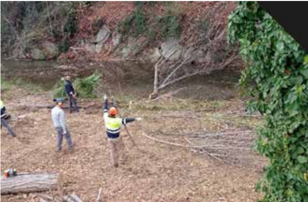
Operarios trabajando en la limpieza. / EPDA
