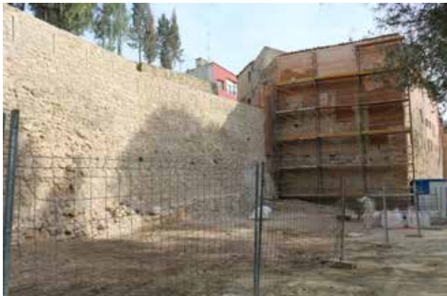
Trabajos de restauración. / EPDA
