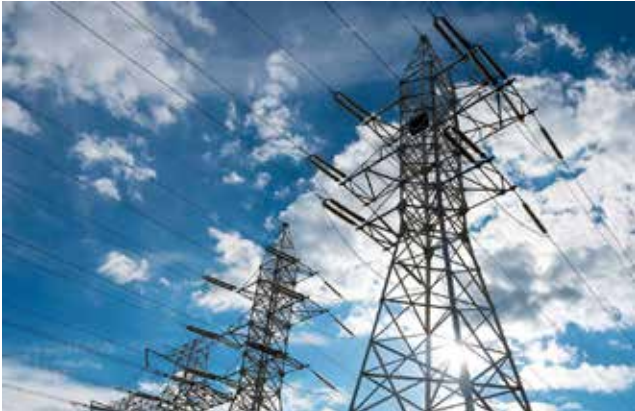
Torres de Muy Alta Tensión. / EPDA
