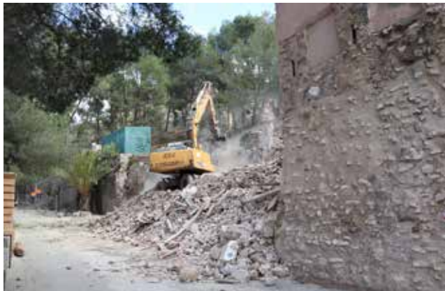
Demolición de los pajares. / EPDA
