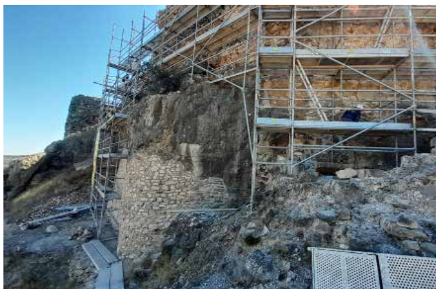
Castillo de Bejís en obras./ EPDA
