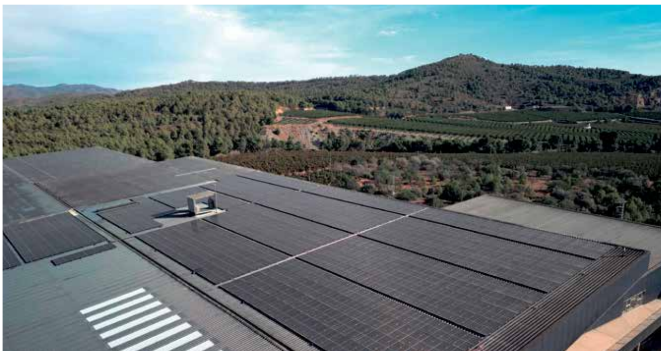
Las nuevas placas solares instaladas en la planta de Algímia d'Alfara por el Consorcio C3/V1 / EPDA
