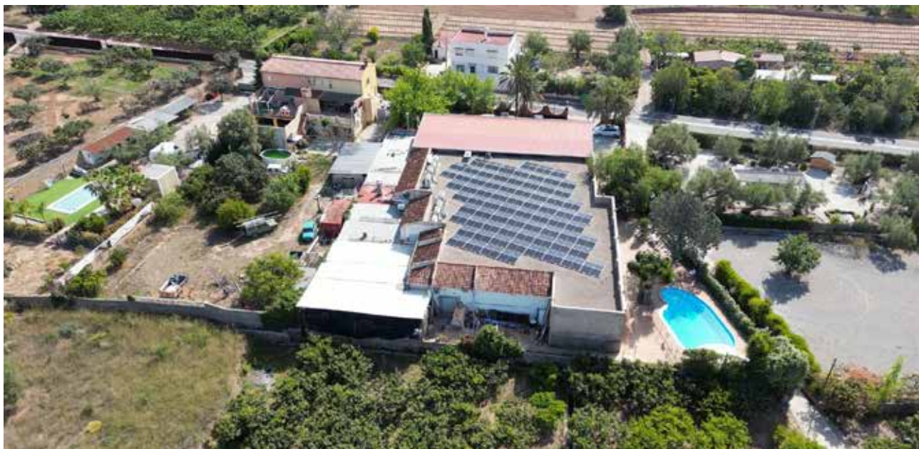
Instalación de CEL Segorbe. / EPDA
