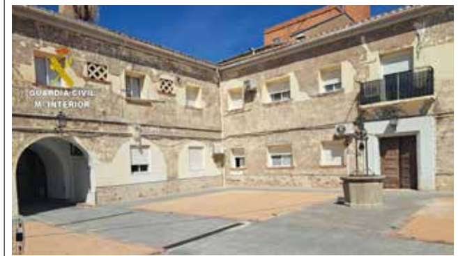
Patio interior del cuartel en obras. / EPDA
