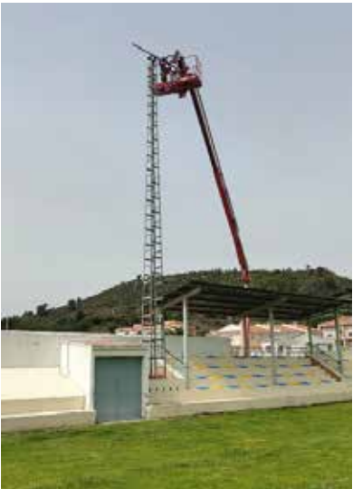
Campo de fútbol en obras. / EPDA
