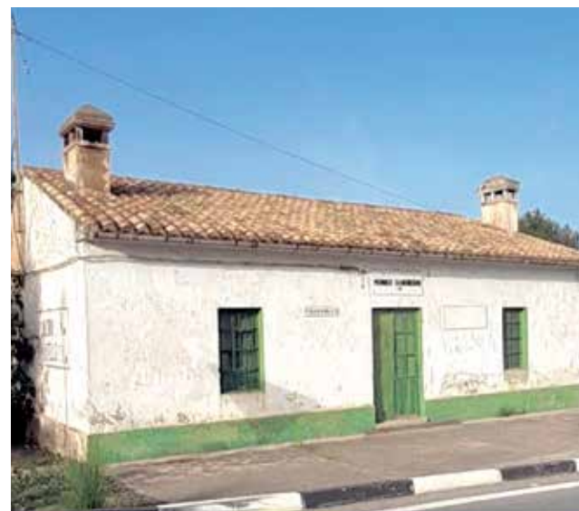
'La Casilla' de Figuerols abans de les obres. / EPDA
