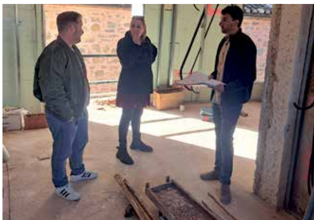
La alcaldesa de Altura visitando las obras. / EPDA
