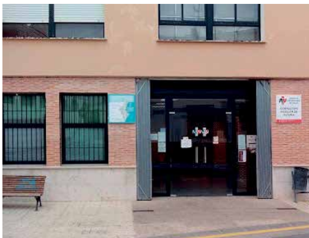
Centro de salud de Altura. / EPDA
