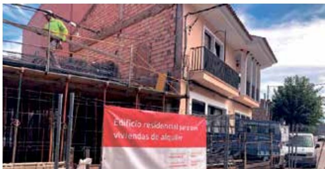
Edificio en construcción./ EPDA
