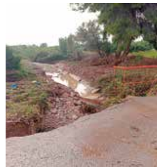
Estat actual del pont. / EPDA
