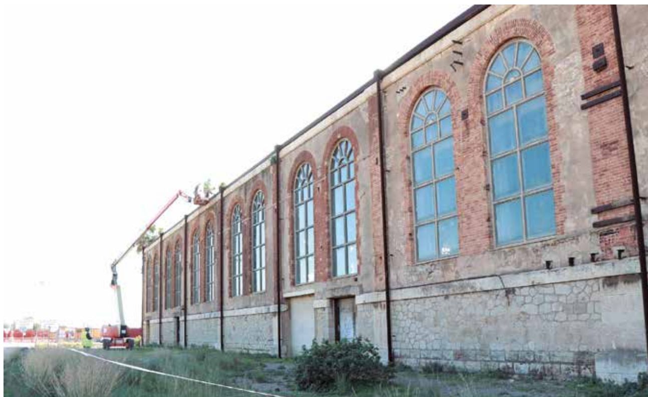
Un operari treballa en l'exterior de la Nau de Tallers. / EPDA
