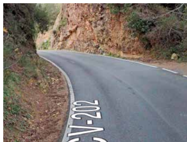
Tramo peligroso de la CV-202. / GOOGLE MAPS
