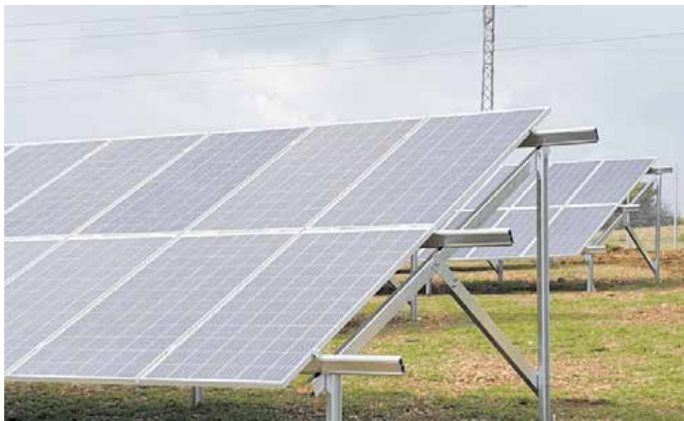
Instalación de Placas fotovoltaicas en tierra / ARCHIVO
