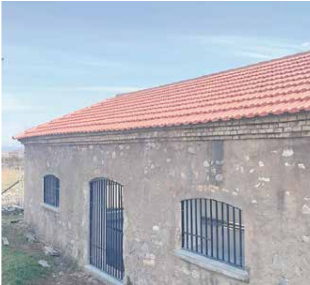
Lavadero de El Toro / EPDA
