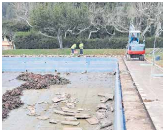
Inicio de los trabajos en la piscina municipal. / EPDA
