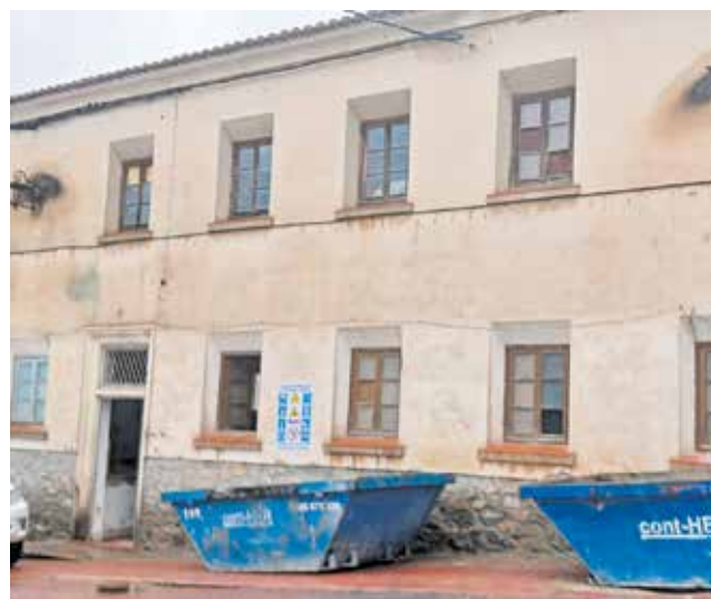
Edificio donde se construirá el centro de día / EPDA
