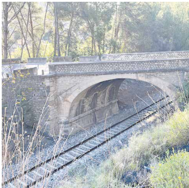
Puente afectado por las obras ferroviarias. / EPDA
