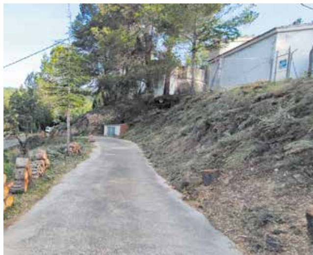
Depósito municipal de agua de Benafer. / EPDA
