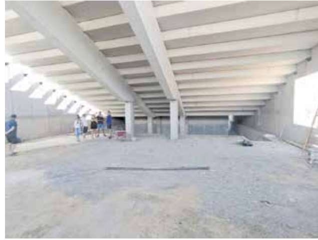
Visita a la nueva fase de las obras. / EPDA
