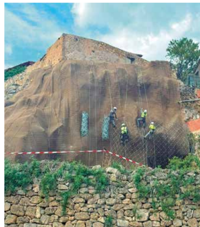
Intervención en el talud de Vallanca. / EPDA
