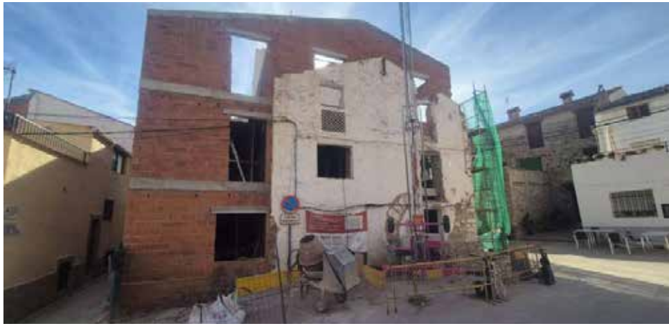
Obras del nuevo ayuntamiento de Argelita. / EPDA
