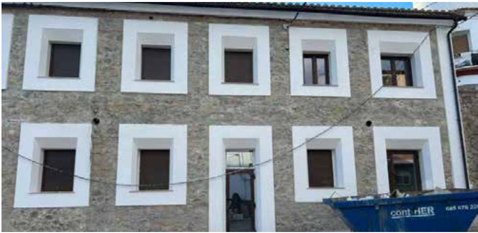
Avance en las obras del nuevo centro de día de Teresa. / EPDA
