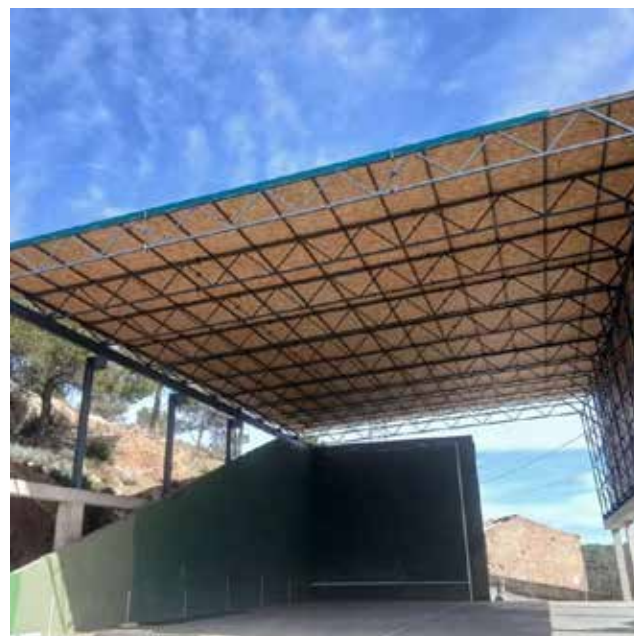
Nueva cubierta del frontón de Villamalur. / EPDA
