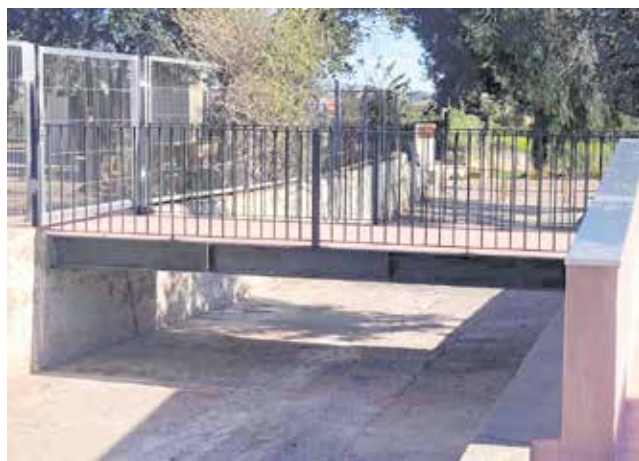
La nova passarel·la al CEIP l'Ermite. / EPDA
