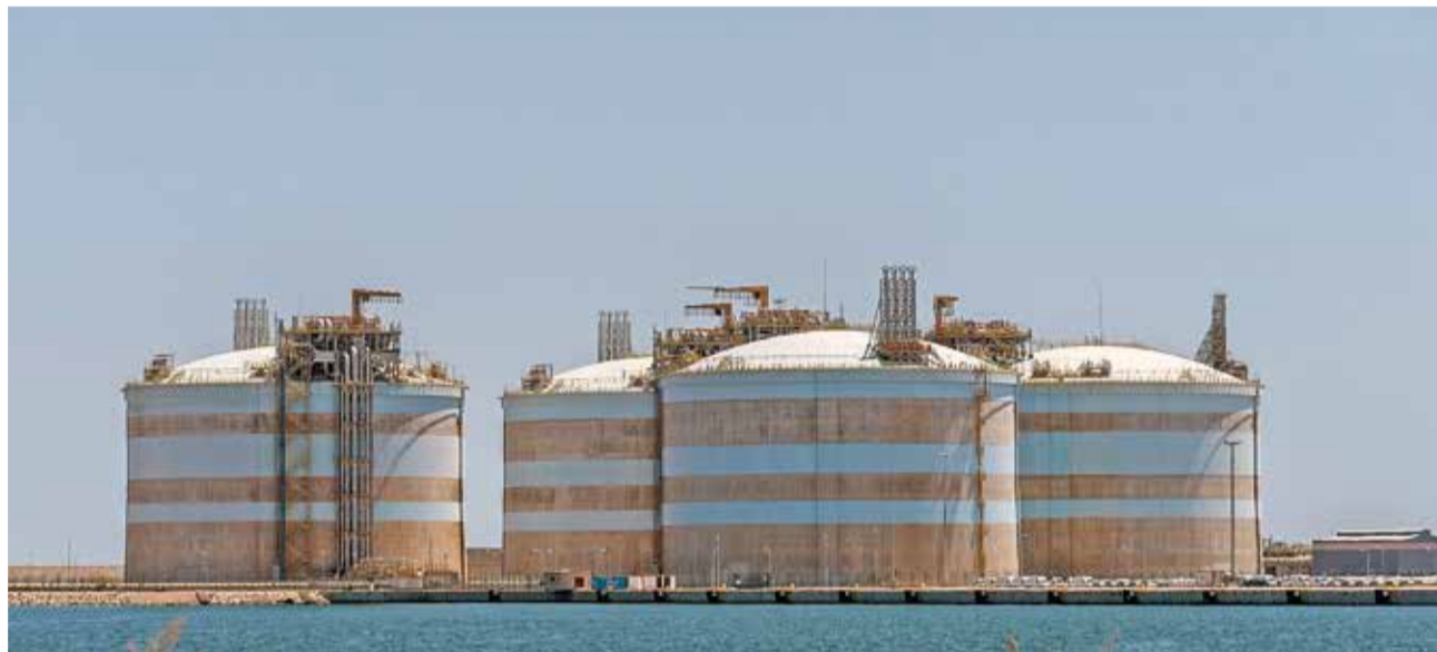
Planta de regasificación. / SAGGAS
