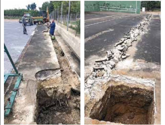
Obras de mejora en el Polideportivo. / EPDA
