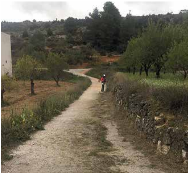
Un operario de Emerge realiza tareas de desbroce. / EPDA
